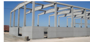
Nave Industrial revestida lateralmente com painéis de betão
