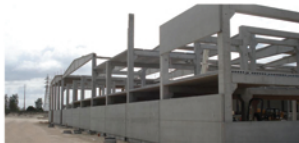
Estrutura Pré-Fabricada com piso intermédio para escadários
